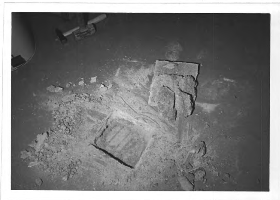
Obr. 3 Postup odkrytí jednotlivých vrstev stropního systému - - Fortit, cementový potěr ve dvou oddělovacích se vrstvách
