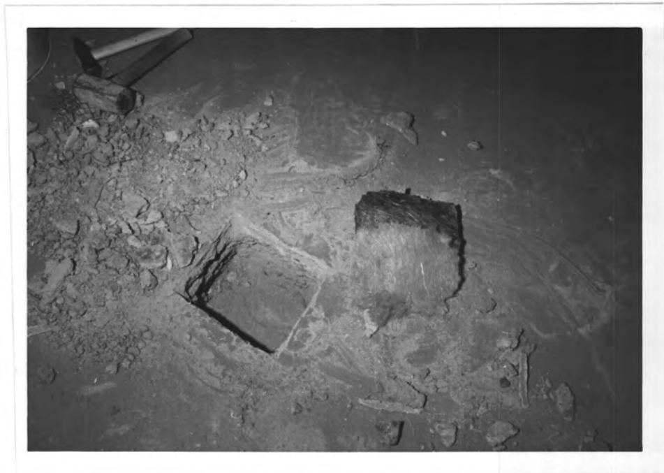
Obr. 5 Další vrstva Calofrig, lepenka, minerální vata
