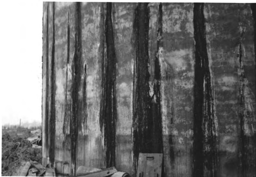
Obr. 5 Porušení věže č. 1 soustavou svislých trhlin a prásaky téměř v celé ploše po naplnění sídlní hmotou
