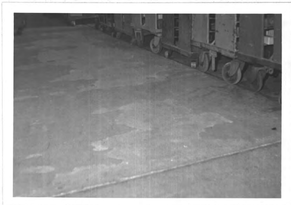
Obr. 1 - Ruční vozíky s pogumovanými kolečkami různého průměru; třetí vozík zprava postrádá pogumování malých koleček. Vpředu totální destrukce podlahoviny, nejen u dilatační spáry
