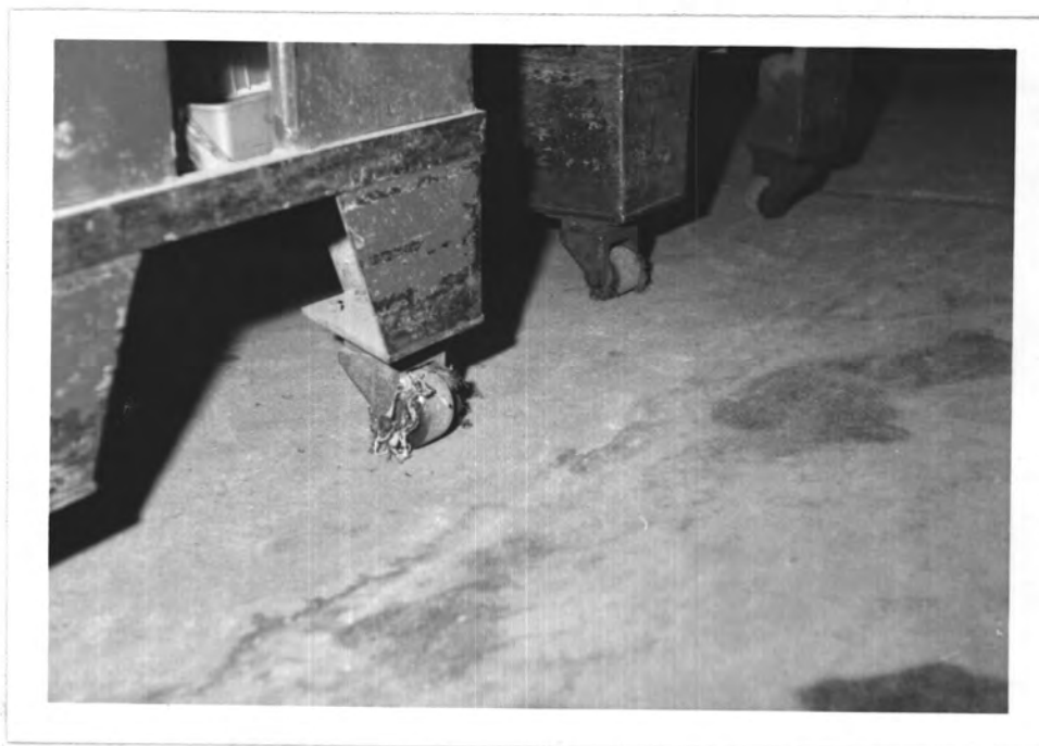
Obr. 1 - Ruční vozíky s pogumovanými kolečkami různého průměru; třetí vozík zprava postrádá pogumování malých koleček. Vpředu totální destrukce podlahoviny, nejen u dilatační spáry
