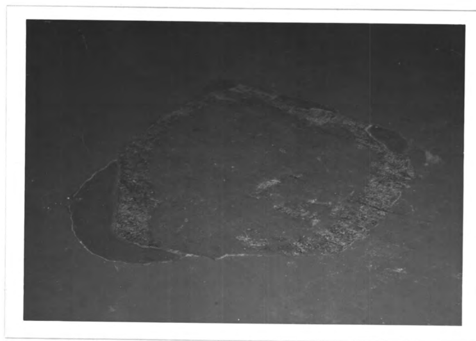
Obr. 5 Odtržená a posádkji epoxidem přilepená část podlahoviny
