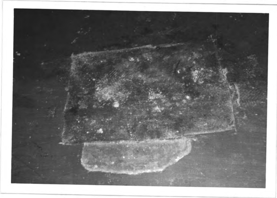
Obr. 6 Postupné opravování porušených částí epoxidovou stěrkou
