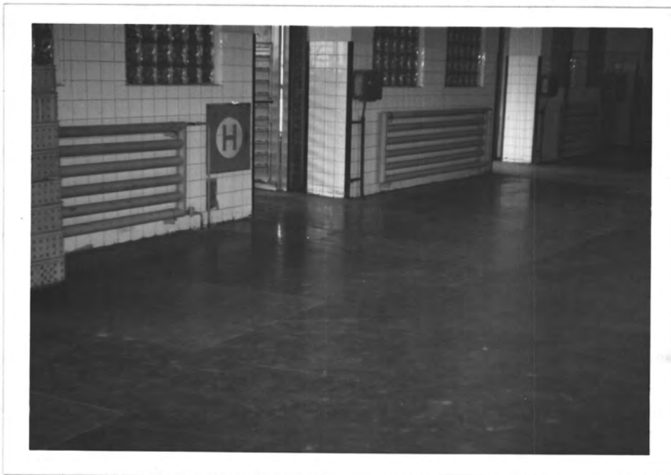
Obr. 2 Opravená část podlahy u expedičních vozů podlahovinou na bázi epoxidových pryskyřic
