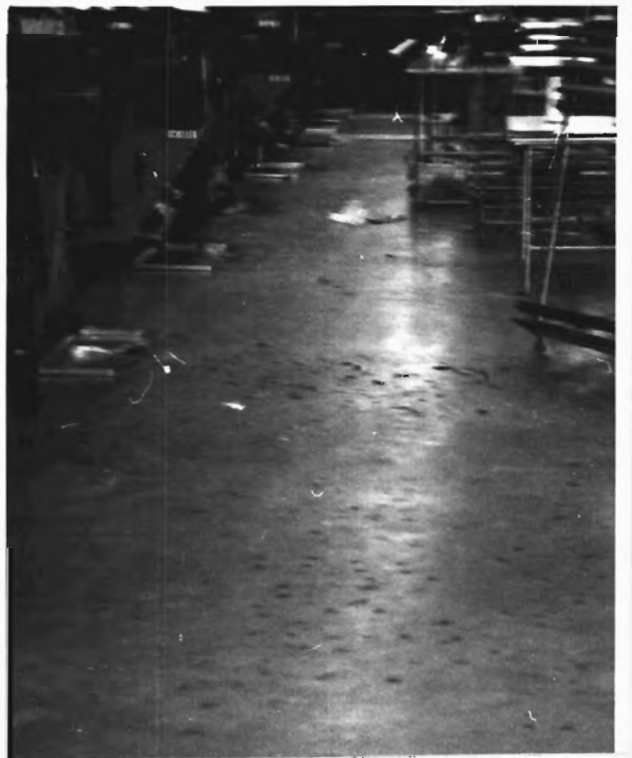
Obr. 2; Výskyt výdutí v některých oblastech provozu pletárny
