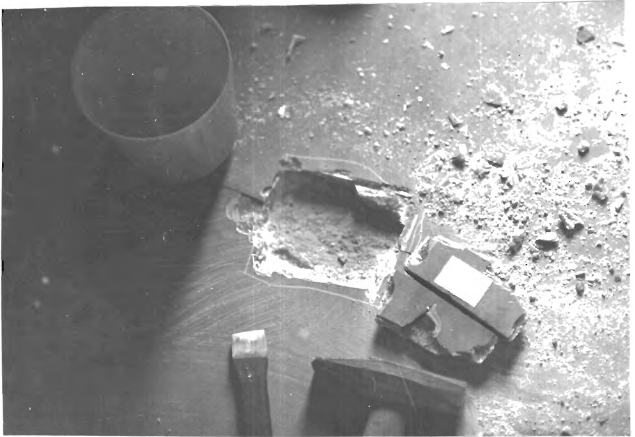
Obr. 7: Trblins povrchové vrstvy podlahoviny pokračuje v plastbetonu i podkladním betonu (hala)
