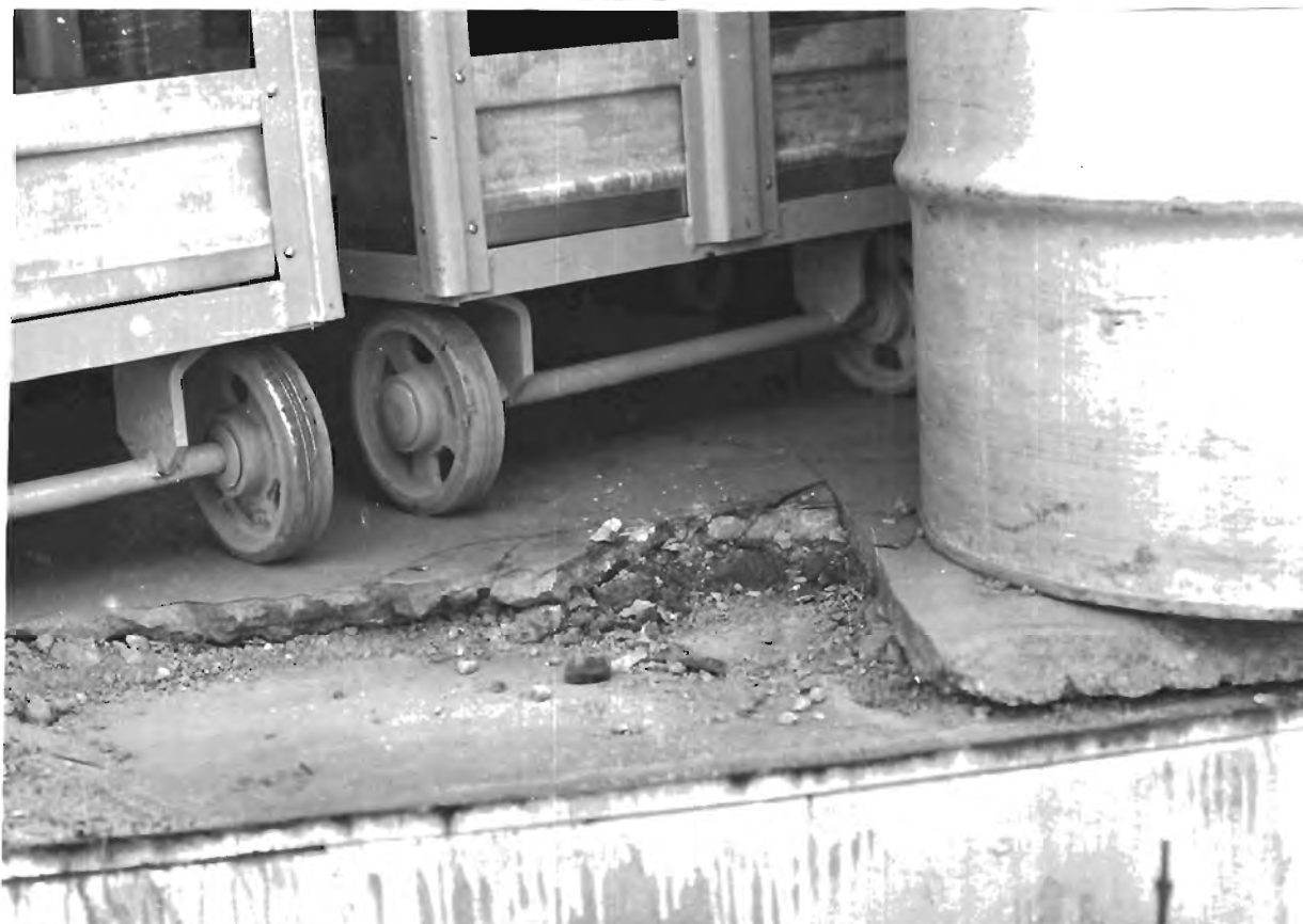
Obr. 3 Detail porušenej podlahoviny, oddelené od konstrukčného betonu spolu s podkladným cementovým petčrem
