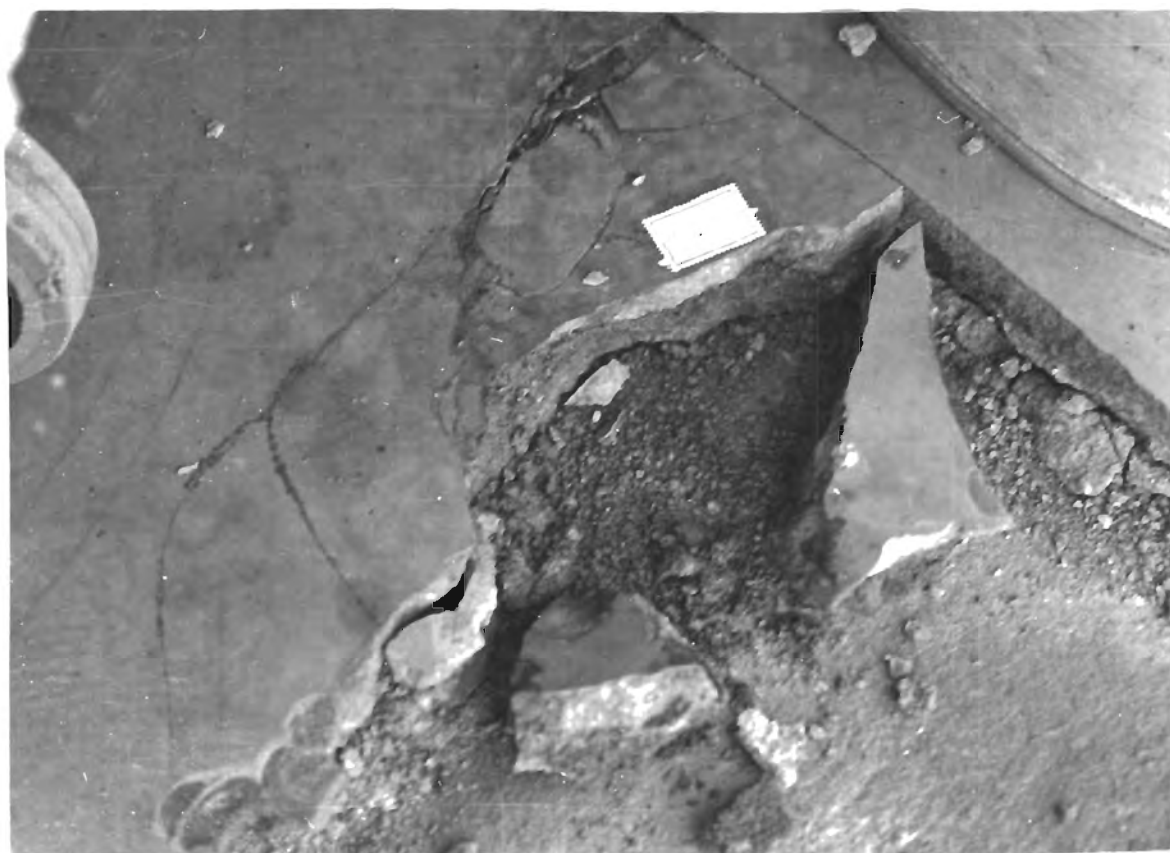
Obr. 3 Detail porušenej podlahoviny, oddelené od konstrukčného betonu spolu s podkladným cementovým petčrem
