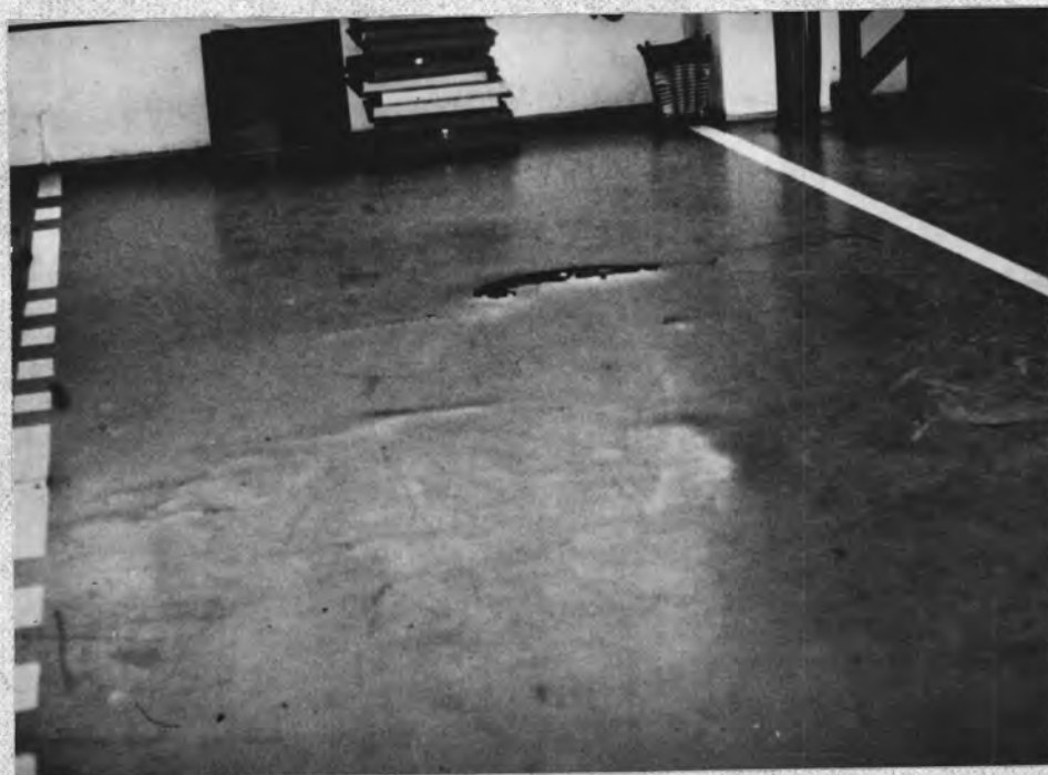
Popraskání puchýřů provozem a miskovitě zdviháním okrajů
