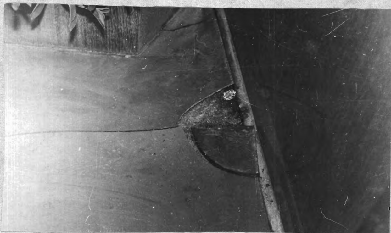
obr. 4 U obvodových stěn a jiných ukončení dochází k horizontálnímu rozdělení plešbetonové vrstvy a z vidění okrajů
