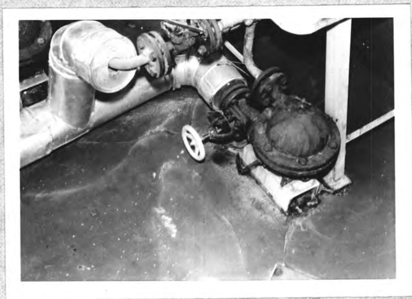
Obr. 2 Trhlina postupující od vyvýšených základů
