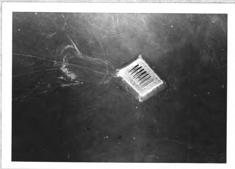
Obr. 4 Trhliny postupující od rohu guly
