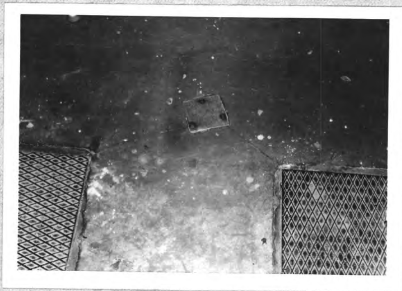
Obr. 4 Trhliny postupující od rohu guly
