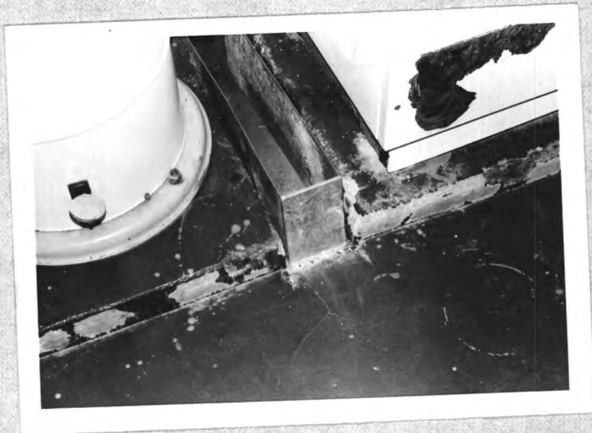
Obr. 2 Trhlina postupující od vyvýšených základů
