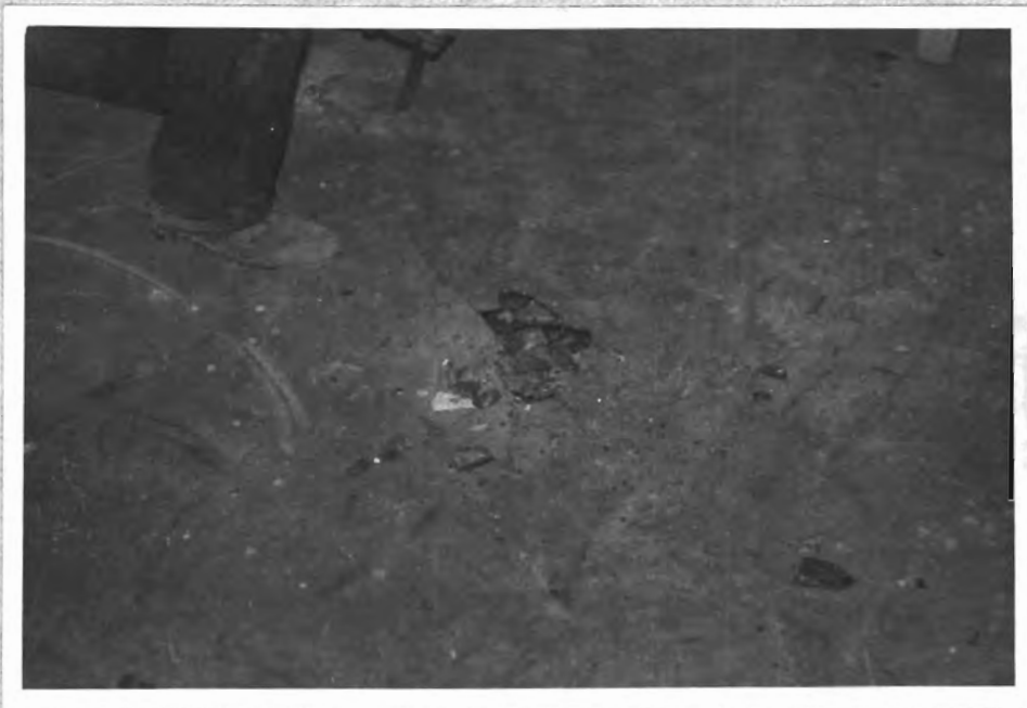
Nepravidelné trhliny v podlahovine v chodbě 198 s nisko- vitě se zdvihajícími okraji
