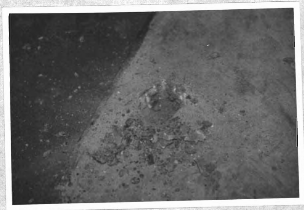
Odebrání vzorku z podlahoviny v blízkosti opravovaného místa ve skladu skla 570
