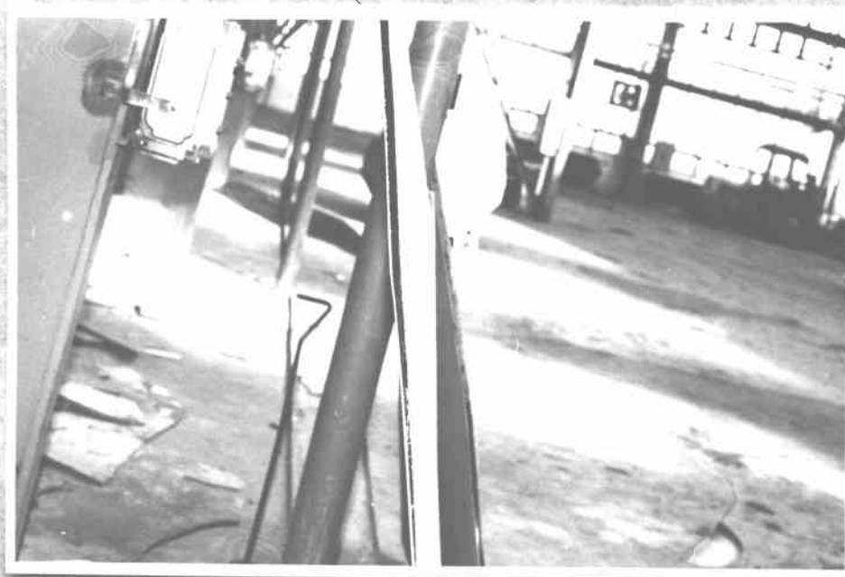
Obr. 2 Nepravidelné trhliny v podlahovině a velké oddělené části /leď 2/
