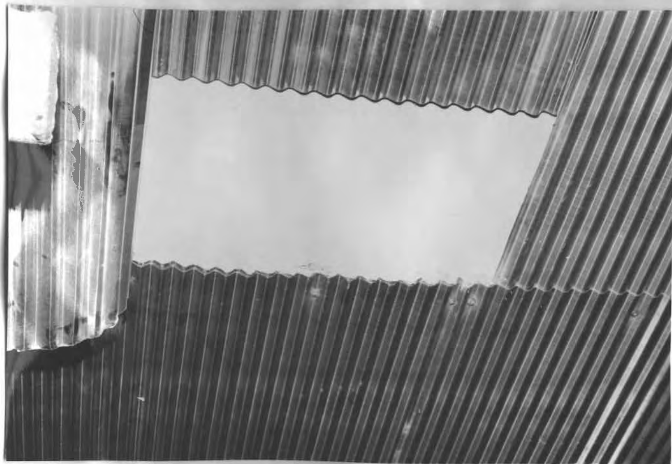
Obr. 6 Pohled na obnaženou část stropu ve třetím místě
