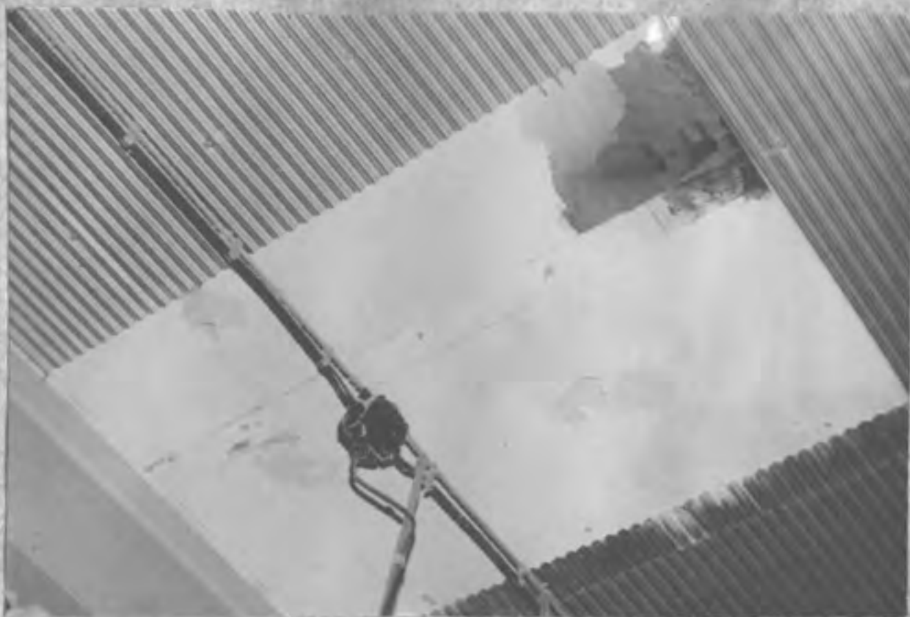
Obr. 1 Pohled na obnaženou část stropu v prvním místě
