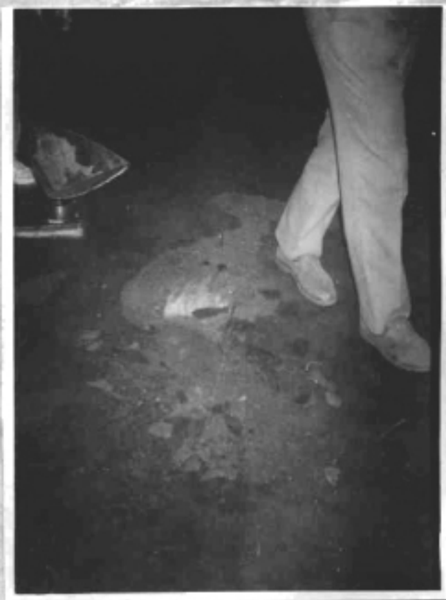
Obr. 2 Lokalizované poruchy uvnitř budov
