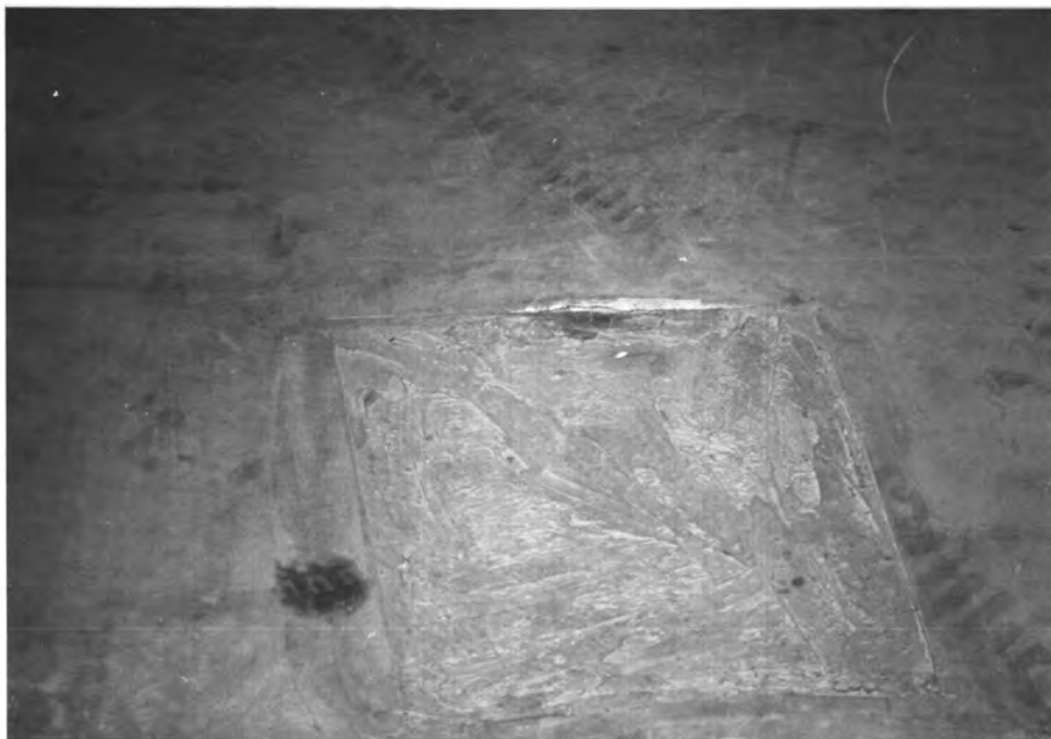
obr.3 Opravená místa polymermaltou
