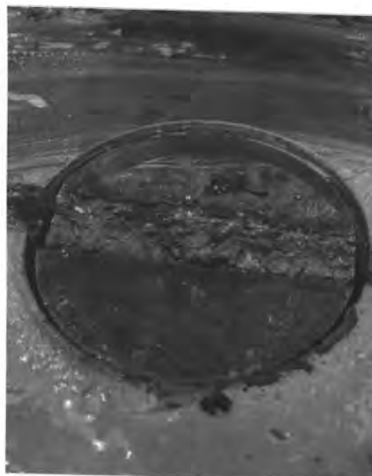
Obr. 12 Vývrt přes dilatační a pracovní spáru 5 v poli GH Obr. 13 Pokles vývrtu po odstranění vrtáku o cca 10 mm
