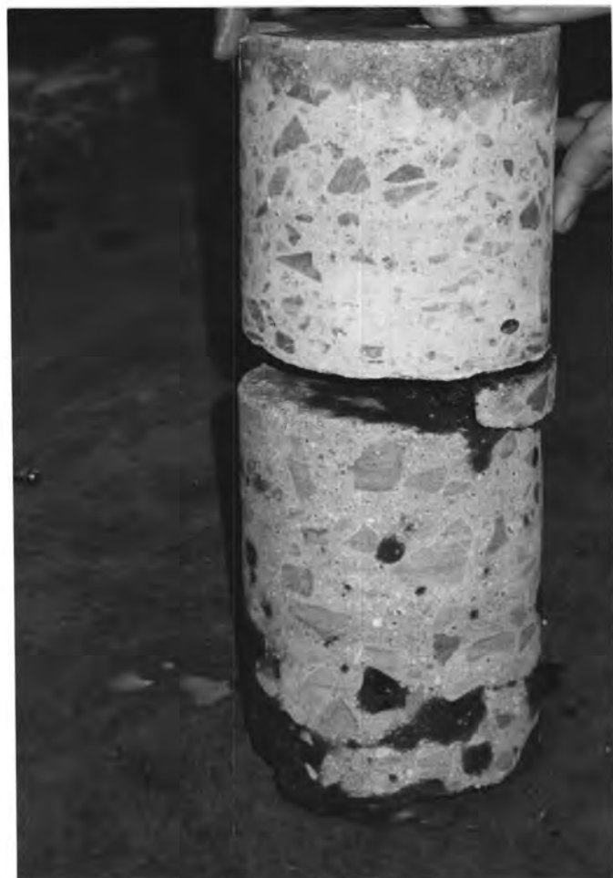
Obr.8 ▲ a obr. 9 ➔ Vývrt v místě EF - 89
