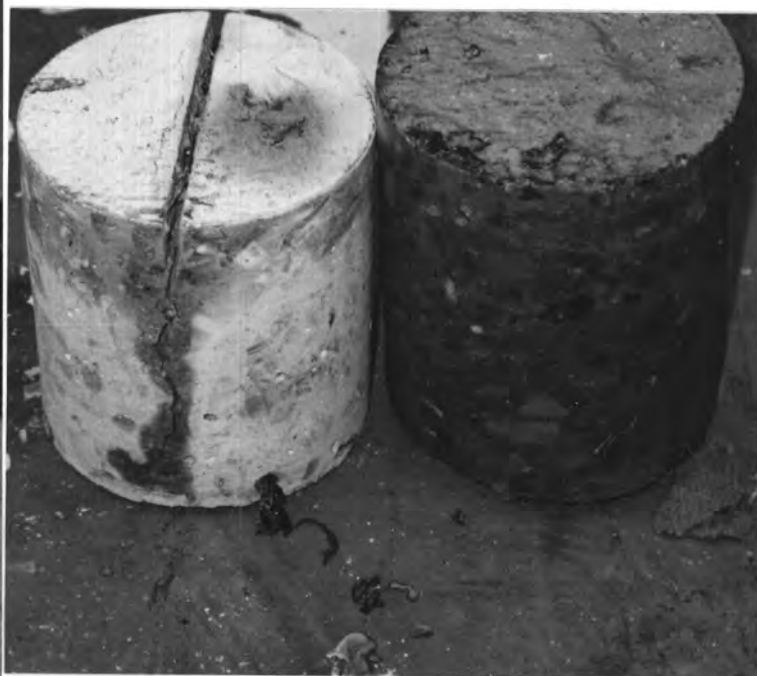
Obr.15 Proříznutá spára ve vývrtu v dilataci 4
