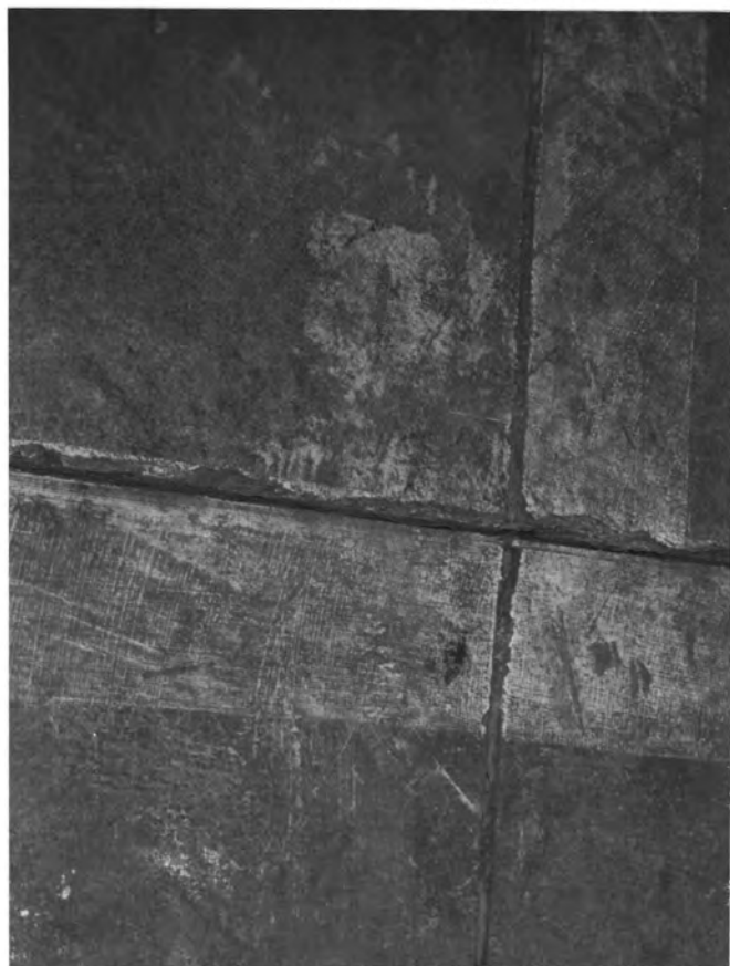
Obr. 3 Vzájemně rozdílná výška jednotlivých polí
