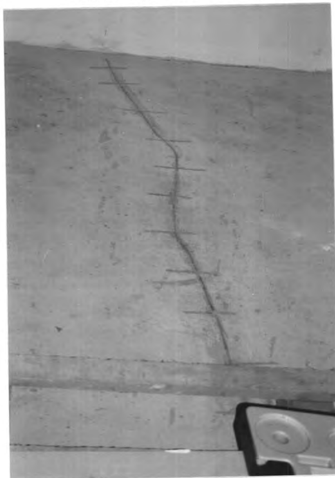
obr. 16 – Vyspravená trhlina „sešitím“ ocelovými kotvami, vše zalití epoxidovou pryskyřicí
