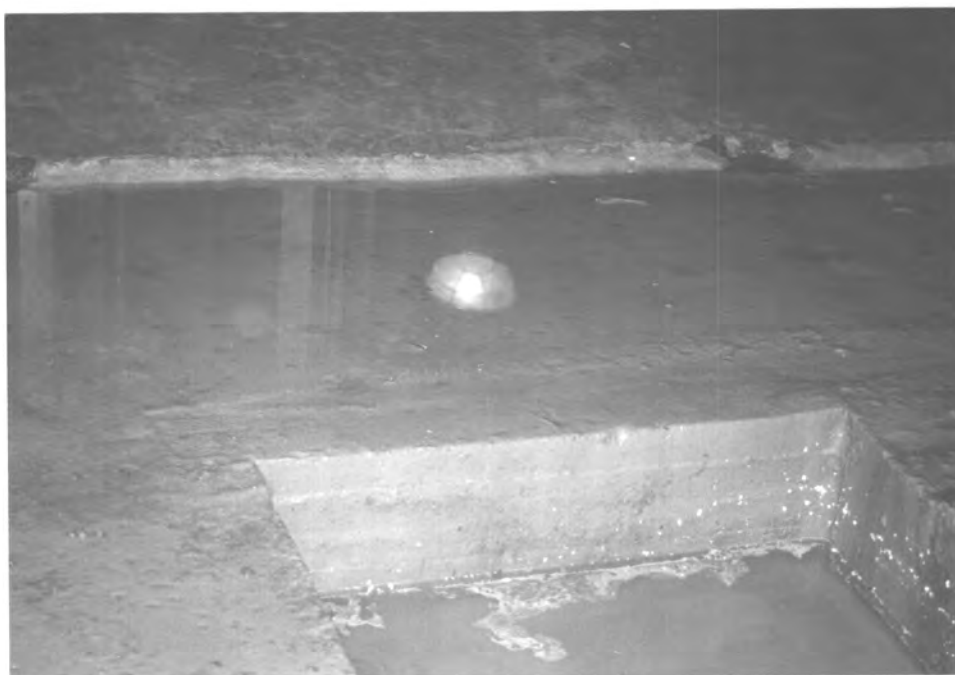
obr. 4 – „Jímka“ v základové desce, v okolí odstraněna betonová mazanina
