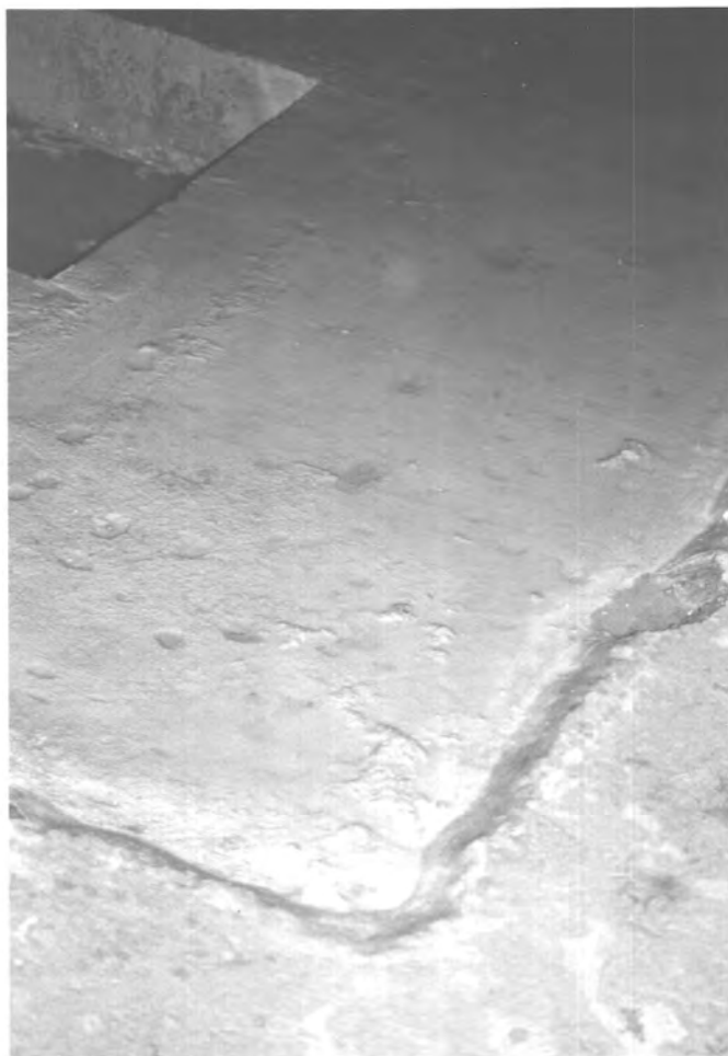
obr. 4 – „Jímka“ v základové desce, v okolí odstraněna betonová mazanina
