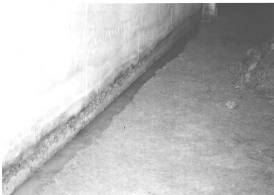
obr. 7, 8, 9 – Vybourané „kanálky“ v betonové mazanině kolem stěn a směrem k jímce
