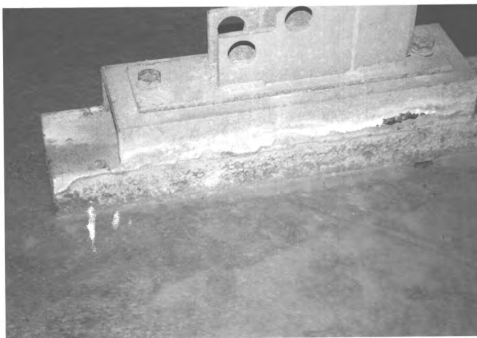
obr. 10 – Osazení ocelové konstrukce garážových stání na základové desce
