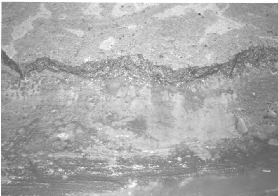
obr. 5 – Vybouraná betonová mazanina v okolí „jímky“
